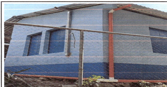
Foto 5: Reparación de RED drenaje y red de agua potable
