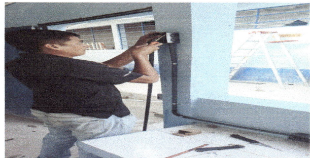
Foto 6: Reparación de sistema eléctrico
