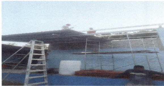
Foto1: Cubierta de la mina
