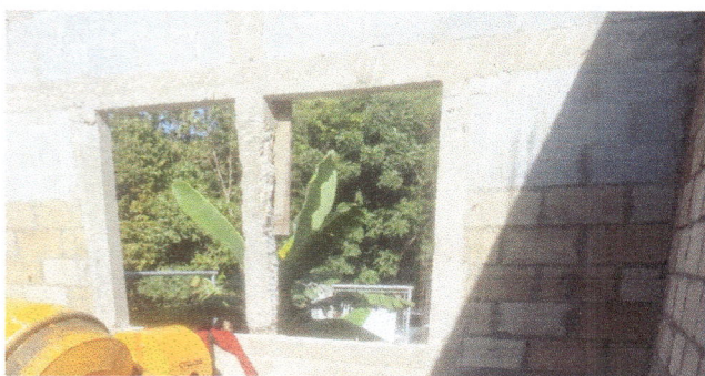
Foto7: Fabricación de ventanas
