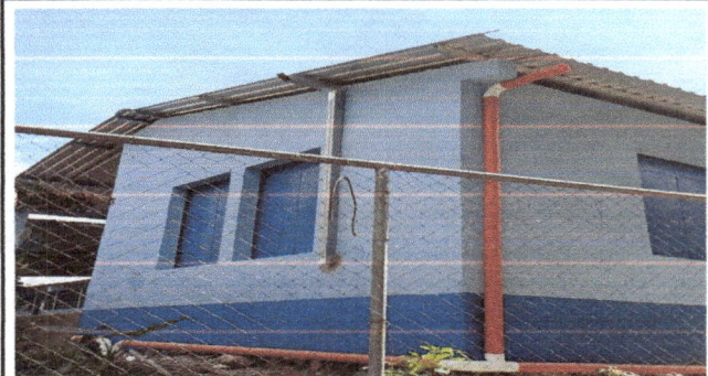
Foto 4: Pintura en muros exteriores e interiores
