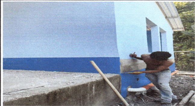
Foto 4: Pintura en muros exteriores e interiores
