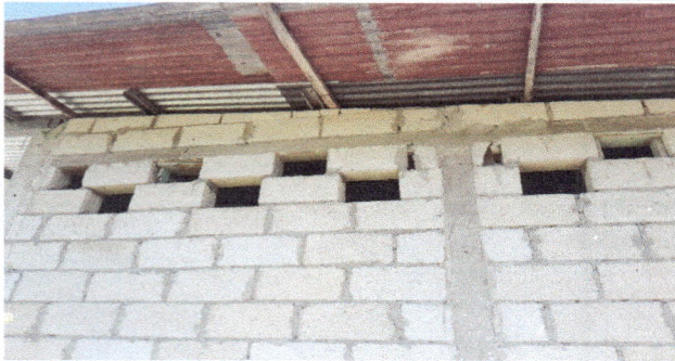
Foto7: Fabricación de ventanas
