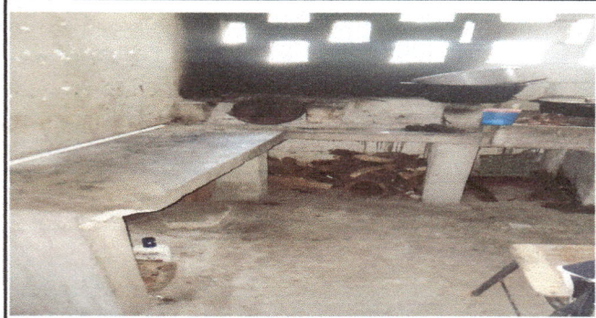
foto 8: Reparación de cocina
