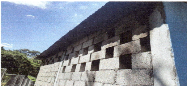
Foto 9: Reparación de repello y cernido de paredes
