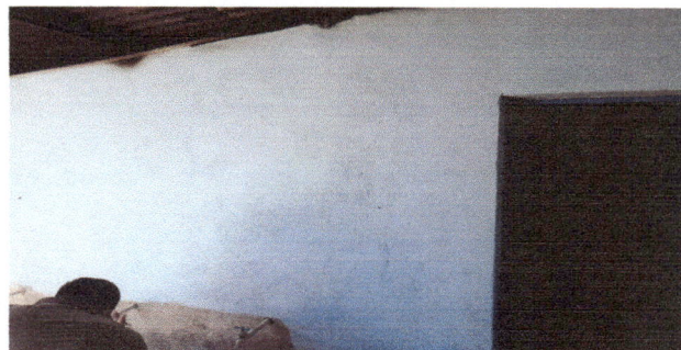
Foto 4: Pintura en muros exteriores e interiores
