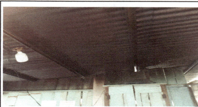
Foto 2: Estructura de techo
