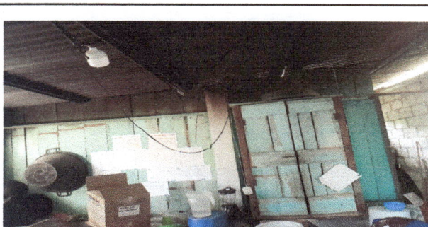
Foto 6: Reparación de sistema eléctrico
