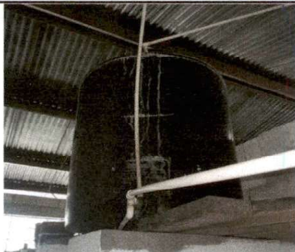
Foto1: sustitucion de deposito de agua 1700 LT
