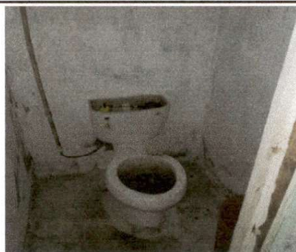
Foto 2: Sustitución de inodoro
