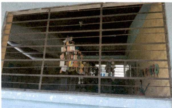
Foto 3: Mantenimientos de balcones de metal
