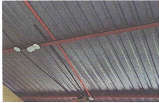
Foto 14: Reparación de cableado eléctrico
