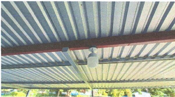
Foto 9: Sustitución de plafoneras
