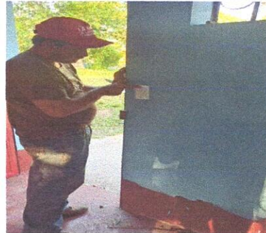
Foto 10: Sustitución de Interruptores Dobles
