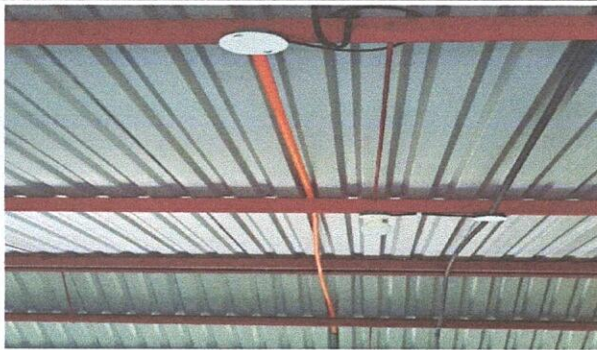
Foto 15: Sustitución de ducto eléctrico + accesorios
