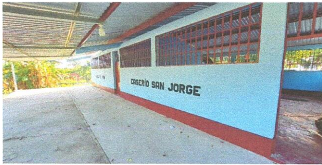
Foto 7: Pintura en muros exteriores e interiores
