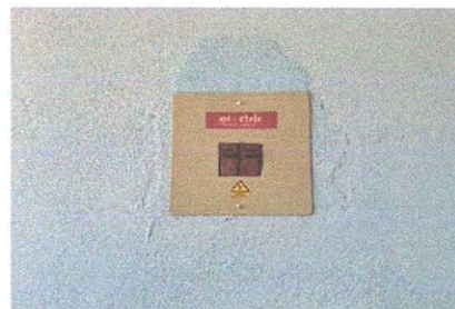
Foto 12: Sustitución de Flapones
