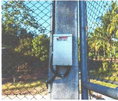
Foto 13: Sustitución de Tablero de Filpones
