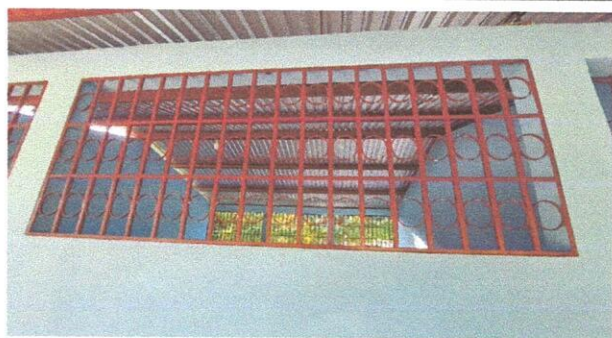
Foto 5: Mantenimiento a balcon de metal
