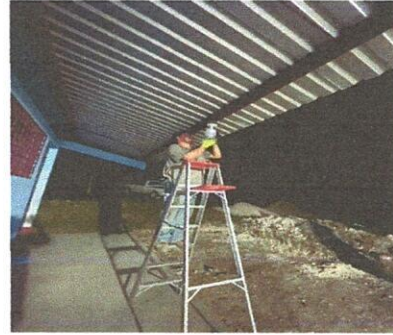
Foto 8: Sustitución de Focos ahorradores
