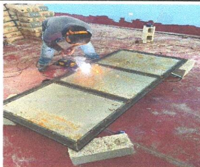
Foto 4: Sustitución de puerta
