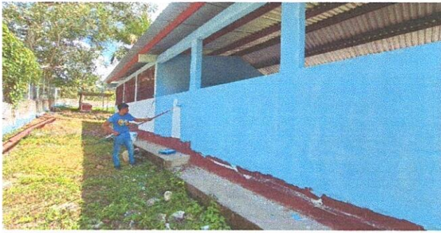
Foto 7: Pintura en muros exteriores e interiores
