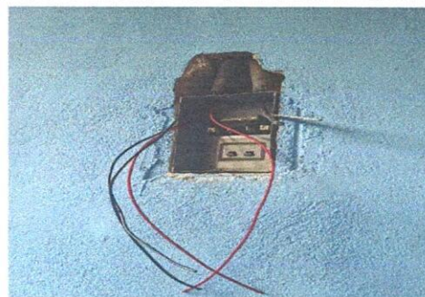
Foto 12: Sustitución de Filpones
