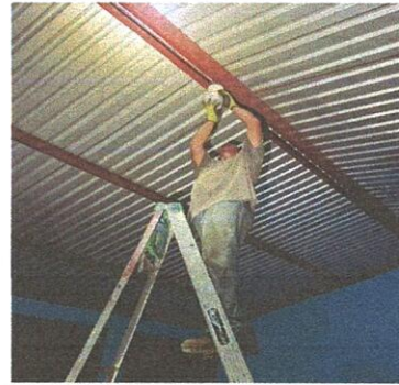
Foto 8: Sustitución de Focos ahorradores
