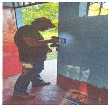
Foto 10: Sustitución de Interruptores Dobles
