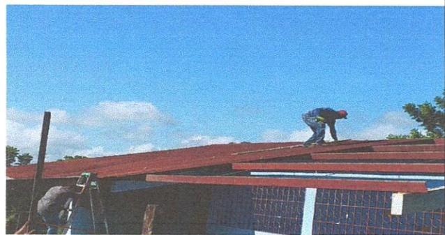
Foto 1: Sustitución de lámina, por lámina troquedala alizinc calibre 26
