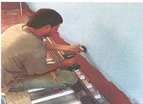
Foto 11: Sustitución de Tomacorrientes Dobles
