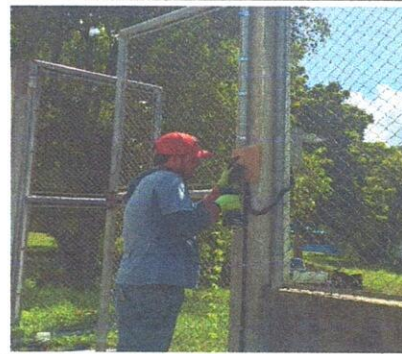
Foto 14: Reparación de cableado eléctrico
