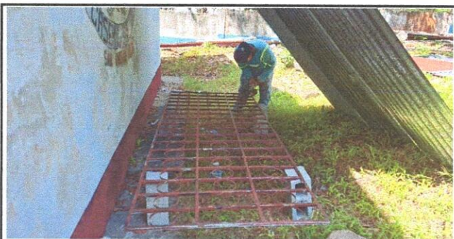
Foto 5: Mantenimiento a balcon de metal
