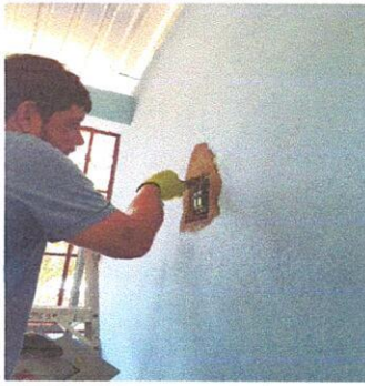
Foto 13: Sustitución de Tablero de Flipones
