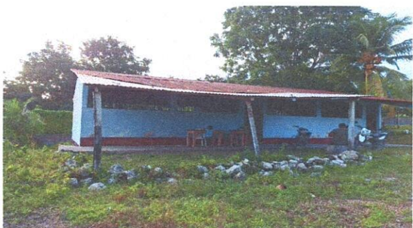
Foto 7: Pintura en muros exteriores e interiores
