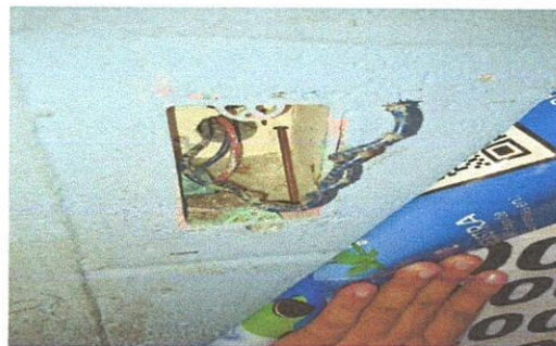
Foto 10: Sustitución de Interruptores Dobles
