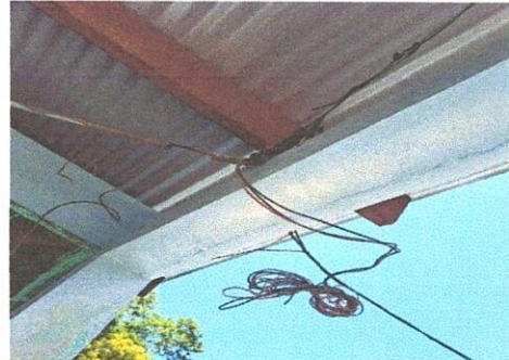
Foto 14: Reparación de cableado eléctrico
