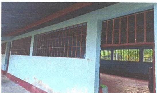
Foto 5: Mantenimiento a balcon de metal
