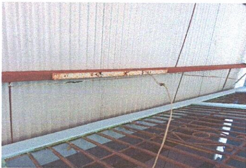
Foto 15: Sustitución de ducto eléctrico + accesorios
