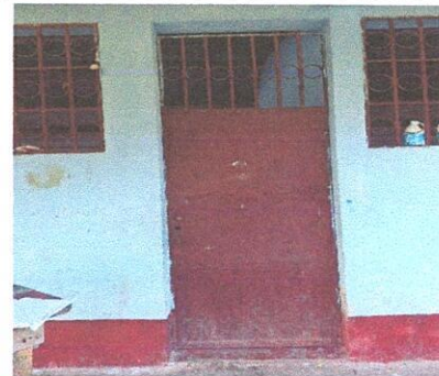
Foto 4: Sustitución de puerta
