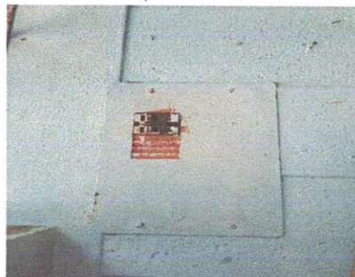
Foto 12: Sustitución de Flipones
