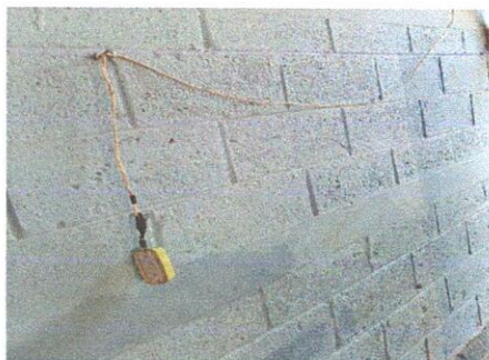
Foto 11: Sustitución de Tomacorrientes Dobles
