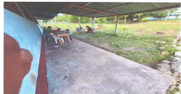
Foto 6: Sustitución piso torta de concreto
