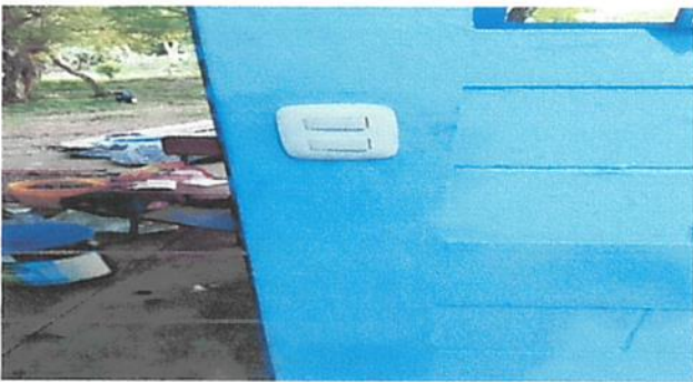
foto 9. sustitucion de interruptor doble
