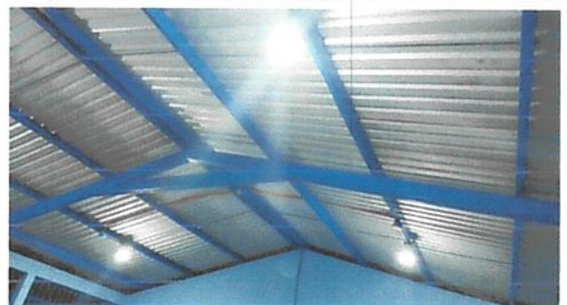
foto 8. sustitucion de plafoneras
