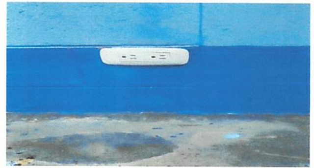
foto. 10 sustitucion de tomacorrientes dobles
