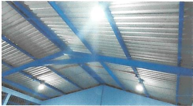
foto 2. mantenimiento a estructura de soporte de metal
