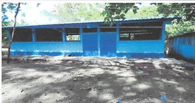
foto 5. pintura en muros exteriores e interiores
