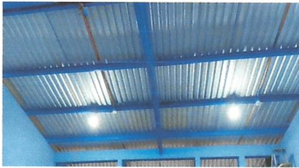
foto 7 sustitucion de focos ahorradores
