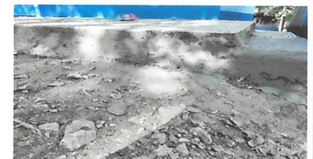
foto 12 reparacion de muro de contencion
