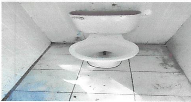
foto 6. sustitucion de inodoros
