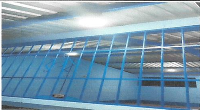
foto 4. mantenimiento a balcones de metal.
