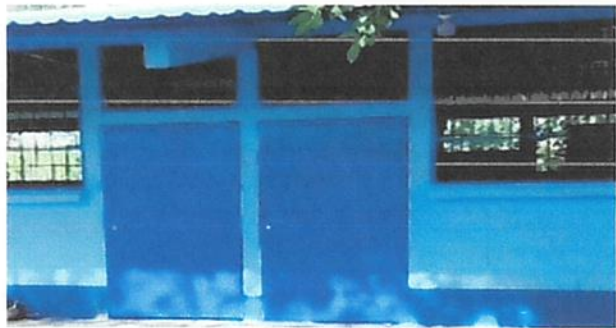
foto 3. sustitucion de puertas
