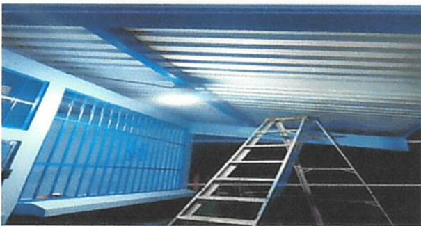
foto 11. reparacion ndel cableado electrico
