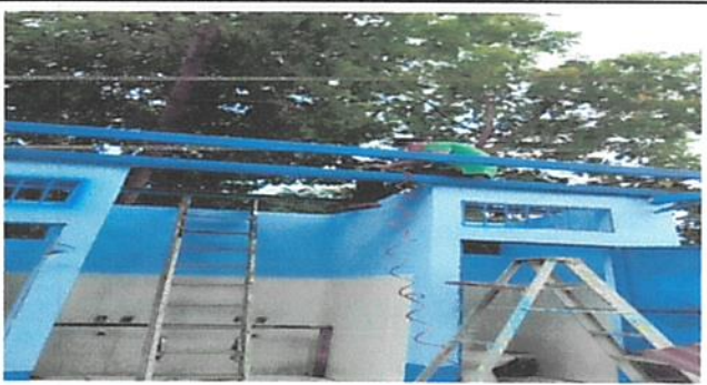
foto 2. mantenimiento a estructura de soporte de metal
