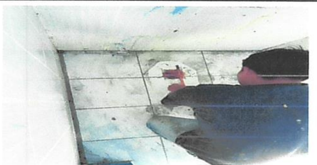
foto 6. sustitucion de inodoros
