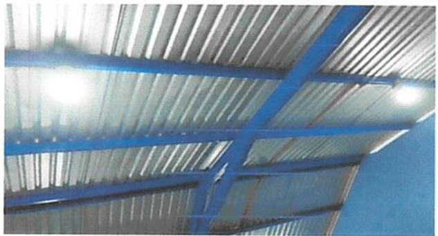
foto 8. sustitucion de plafoneras
