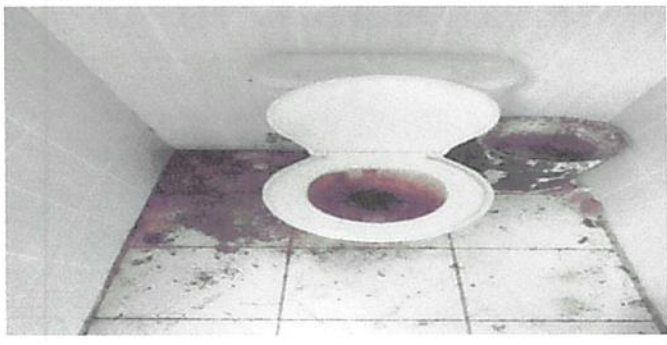
foto 6. sustitucion de inodoros
