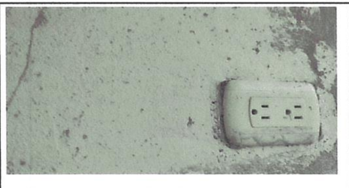
foto. 10 sustitucion de tomacorrientes dobles
