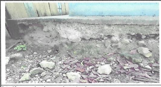
foto 12 reparacion de muro de contencion
