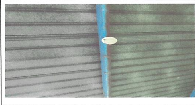
foto 7 sustitucion de focos ahorradores
