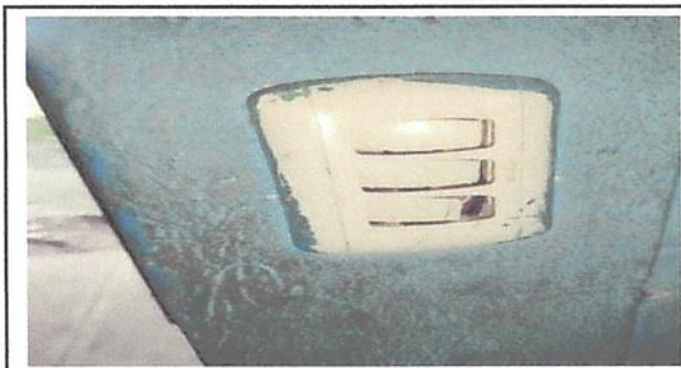
foto 9. sustitucion de interruptor doble
