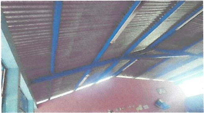
foto 2. mantenimiento a estructura de soporte de metal
