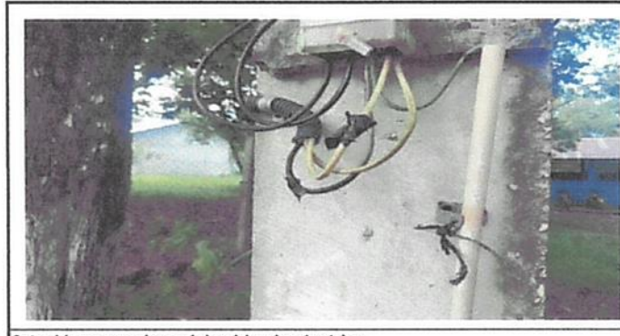
foto 11. reparacion ndel cableado electrico
