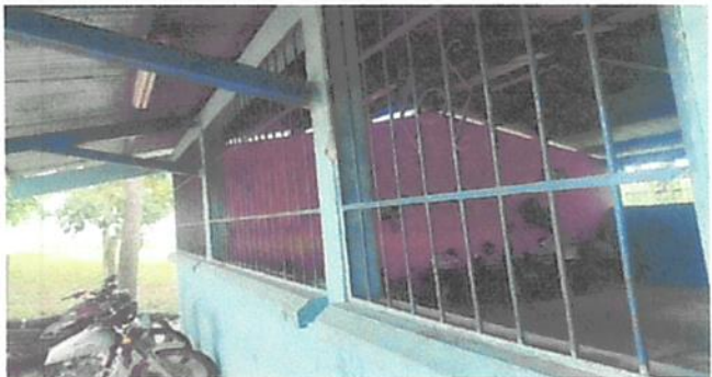
foto 4. mantenimiento a balcones de metal.
