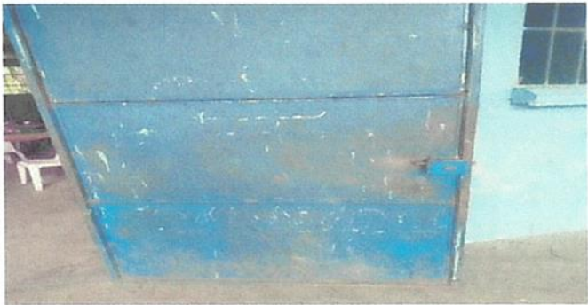
foto 3. sustitucion de puertas
