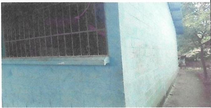
foto 5. pintura en muros exteriores e interiores
