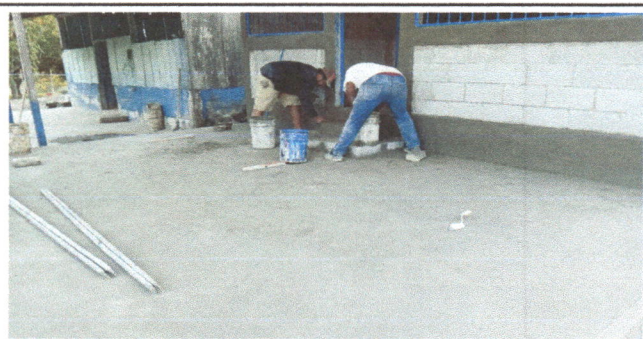
FOTO 5. SUSTITUCION DE TORTA DE CONCRETO
