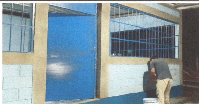
FOTO No. 3 SUSTITUCION DE PUERTA
