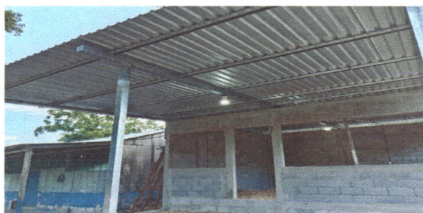
FOTO 1 SUSTITUCION DE LAMINA, POR LAMINA TROQUELADA ALUZINC CALIBRE 26
