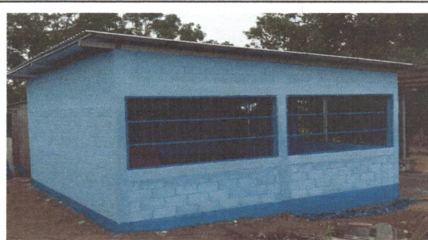
FOTO 4. SUSTITUCION DE BALCONES DE METAL
