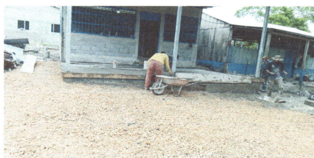
FOTO 5. SUSTITUCION DE TORTA DE CONCRETO
