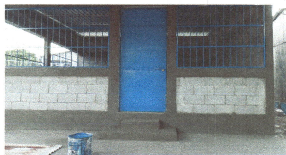
FOTO 4. SUSTITUCION DE BALCONES DE METAL
