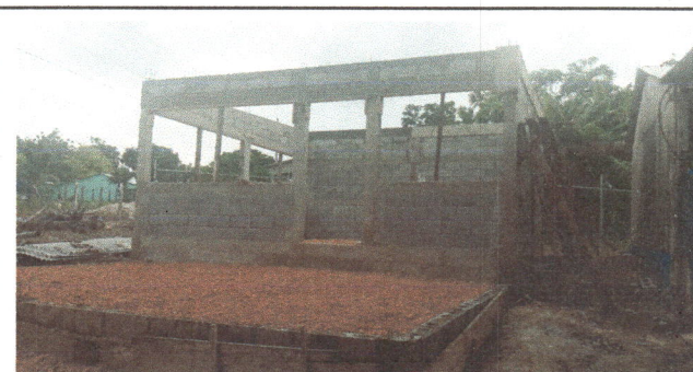
FOTO No. 6 REPARACION DE MURO PERIMETRAL DE BLOCK
