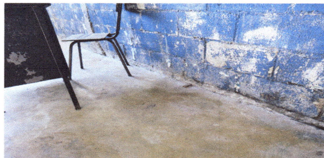
FOTO No. 6 REPARACION DE MURO PERIMETRAL DE BLOCK
