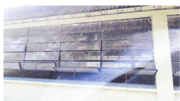
FOTO 4. SUSTITUCION DE BALCONES DE METAL
