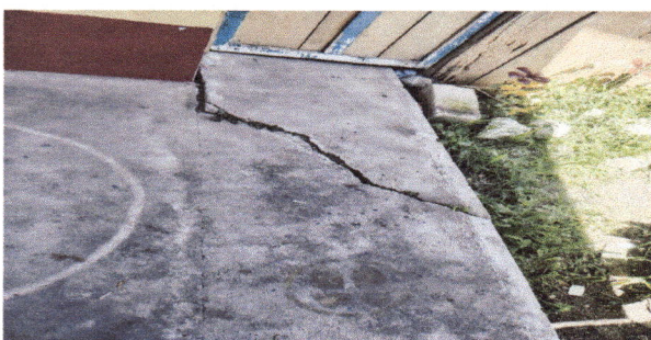
FOTO 5. SUSTITUCION DE TORTA DE CONCRETO
