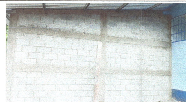
FOTO 9. REPARACION DE MURO PERIMETRAL DE BLOCK
