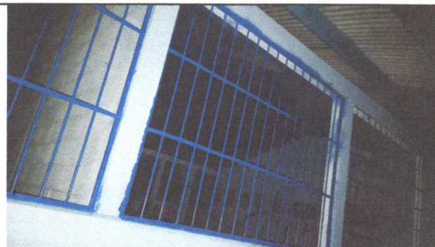
FOTO 4. SUSTITUCION DE BALCON DE METAL
