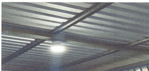
11. SUSTITUCION DE PLAFONERAS
