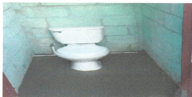
FOTO 6. SUSTITUCION DE INODOROS
