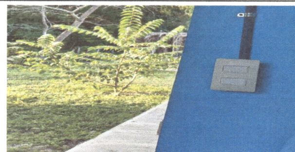
12. SUSTITUCION DE INTERRUPTORES DOBLES
