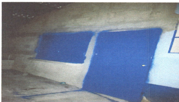
FOTO 3 SUSTITUCION DE PUETRA
