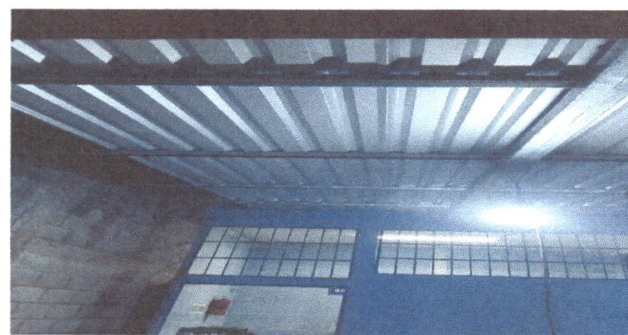
FOTO 10. SUSTITUCION DE FOCOS AHORRADORES
