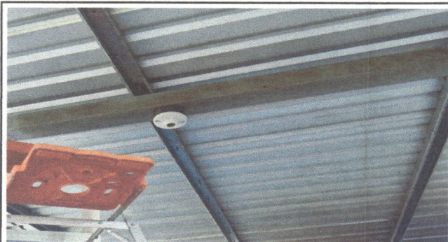
FOTO 11. SUSTITUCION DE PLAFONERAS
