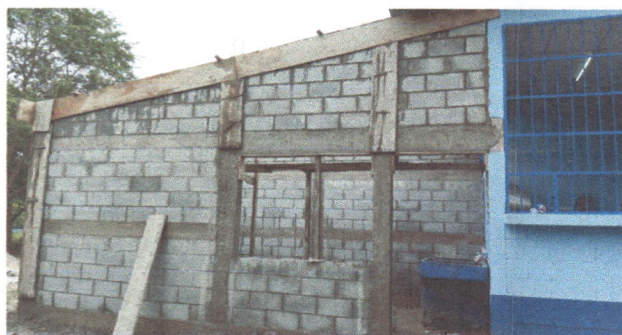
FOTO 9. REPARACION DE MURO PERIMETRAL DE BLOCK
