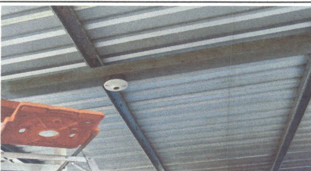
FOTO 11. SUSTITUCION DE PLAFONERAS
