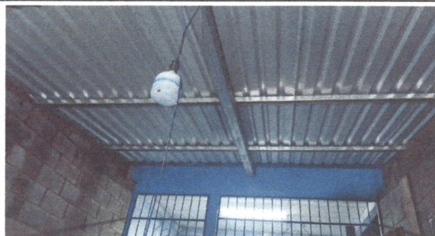
FOTO 10. SUSTITUCION DE FOCOS AHORRADORES
