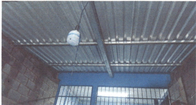
FOTO 10. SUSTITUCION DE FOCOS AHORRADORES
