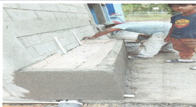
FOTO 7. SUSTITUCION DE MIGITORIO
