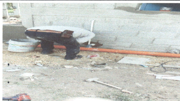
FOTO 8. SUSTITUCION DE TUBERIA LINEA PRINCIPAL
