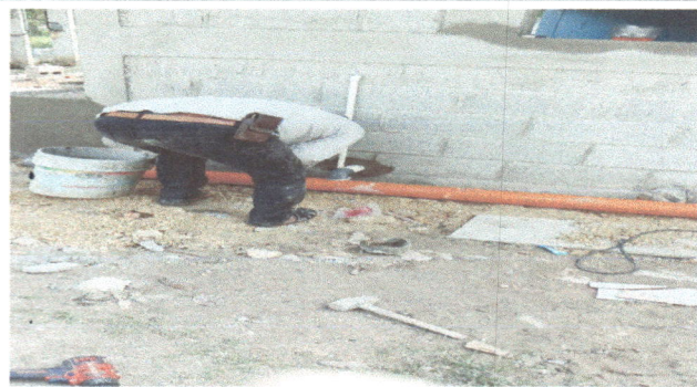
FOTO 8. SUSTITUCION DE TUBERIA LINEA PRINCIPAL
