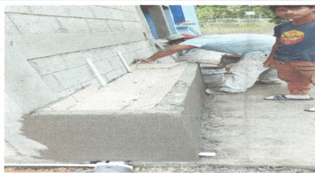
FOTO 7. SUSTITUCION DE MIGITORIO
