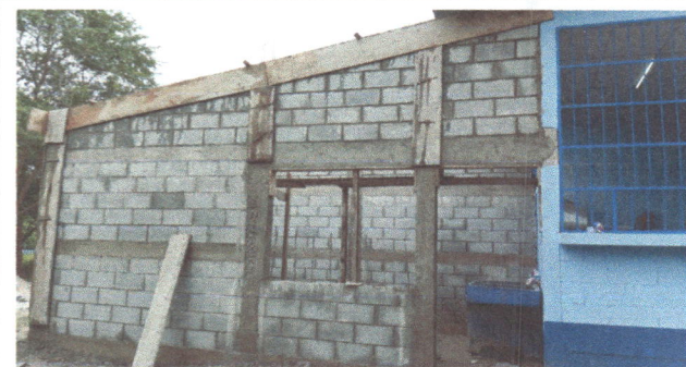
FOTO 9. REPARACION DE MURO PERIMETRAL DE BLOCK
