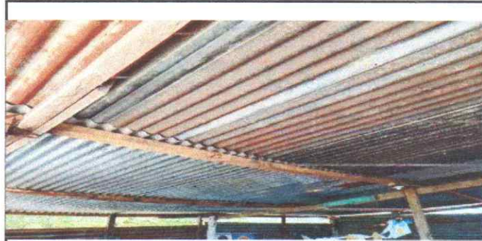
FOTO 6. SUSTITUCION DE ESTRUCTURA DE SOPORTE DE MADERA POR METAL
