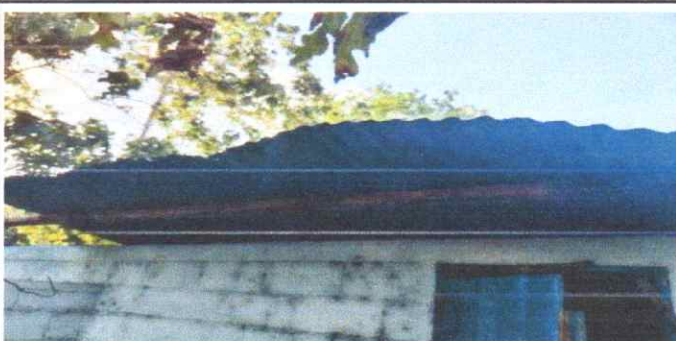
FOTO 5. SUSTITUCION DE LAMINA, POR LAMINA TROQUELADA ALIZIN CALIBRE 26.
