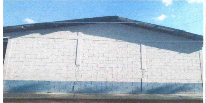
FOTO 10. PINTURA EN MUROS EXTERIOR E INTERIOR
