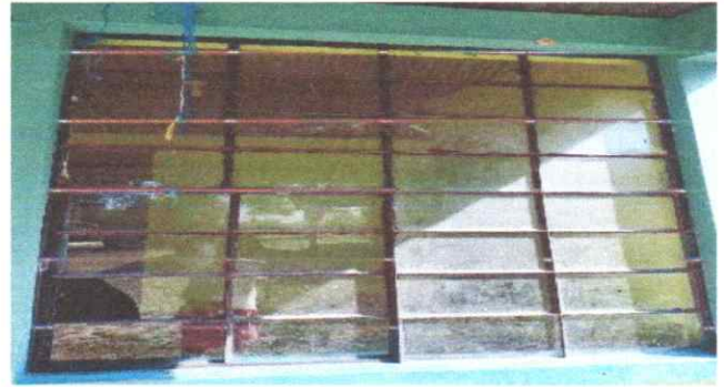
FOTO 8. SUSTITUCION DE BALCON DE METAL
