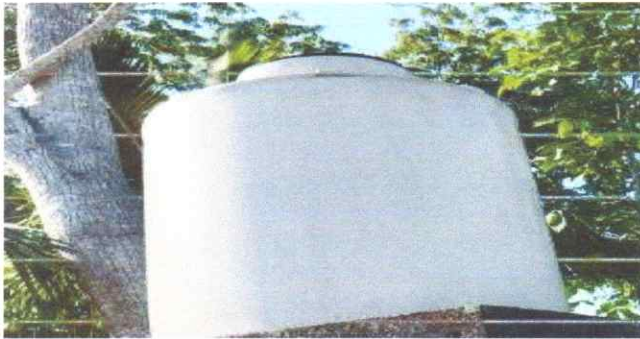
FOTO 9. SUSTITUCION DE DEPOSITO DE AGUA DE 1,700 LITROS
