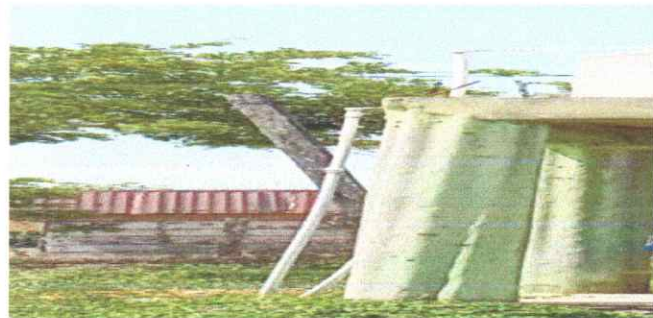
FOTO 11. REPARACION DE TUBERIA PRINCIPAL
