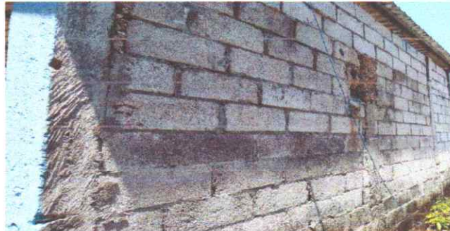
FOTO 2. REPARACION DE MURO
