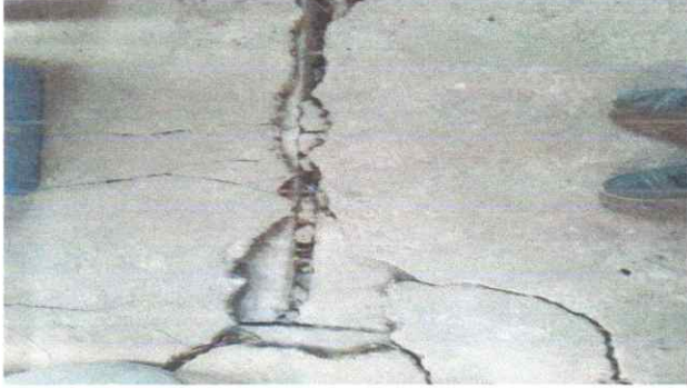
FOTO 7. SUSTITUCION DE PISO DE TORTA DE CONCRETO
