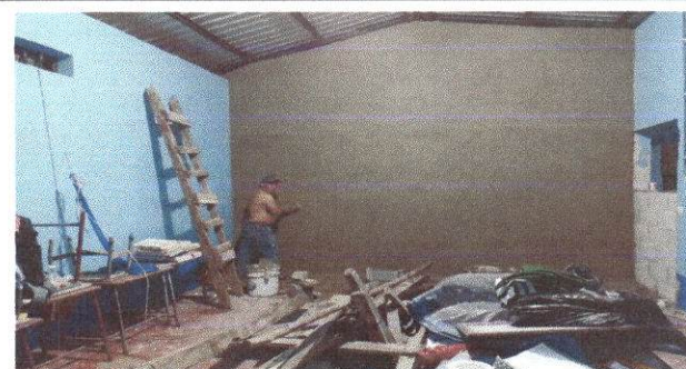
Foto 6: Reparación de muro perimetral de block
