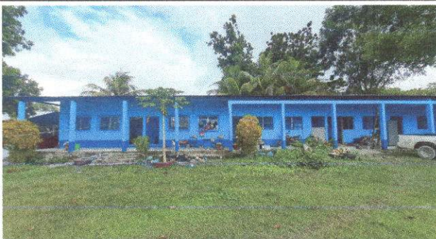
Foto 5: Pintura en muros exteriores e interiores
