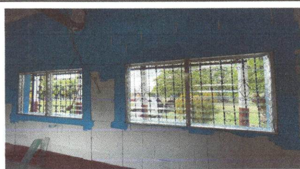
Foto 2: Fabricación e instalación de marcos de aluminio mil finish
