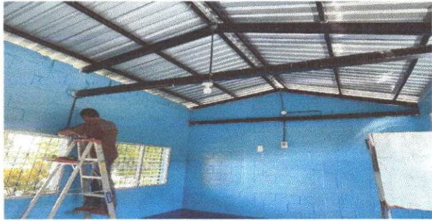
Foto 7: Sustitución de ducto eléctrico + accesorios
