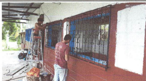
Foto 3: Mantenimiento a balcones de metal
