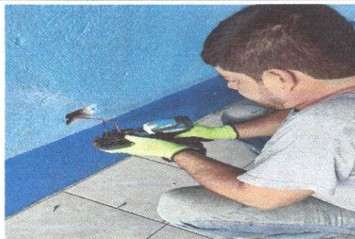
Foto 8: Sustitucion de tomacorrientes Dobles
