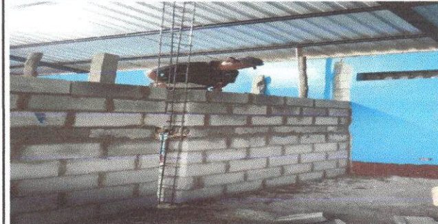
Foto 6: Reparación de muro perimetral de block
