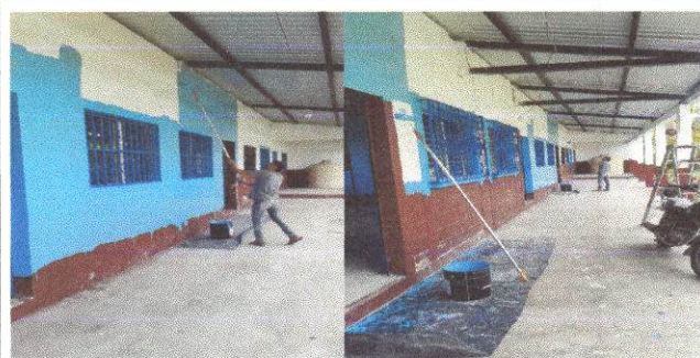
Foto 5: Pintura en muros exteriores e interiores
