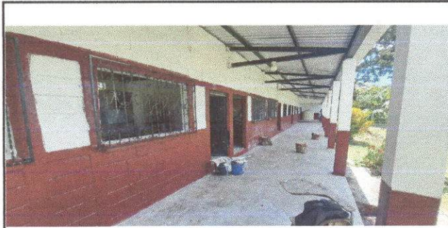
Foto 3: Mantenimiento a balcones de metal
