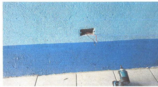
Foto 8: Sustrución de tomacorrientes Dobles
