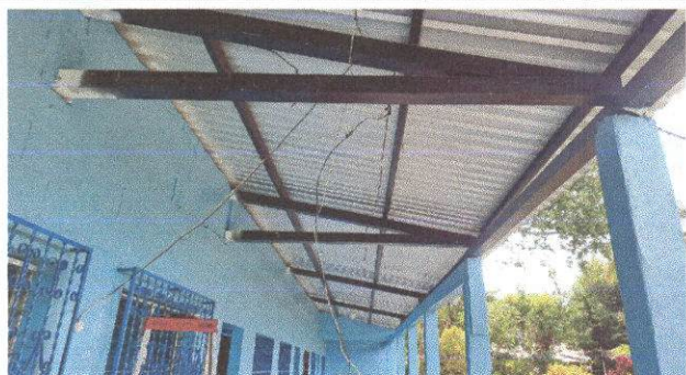
Foto 7: Sustrución de ducto elétrico + accesorios
