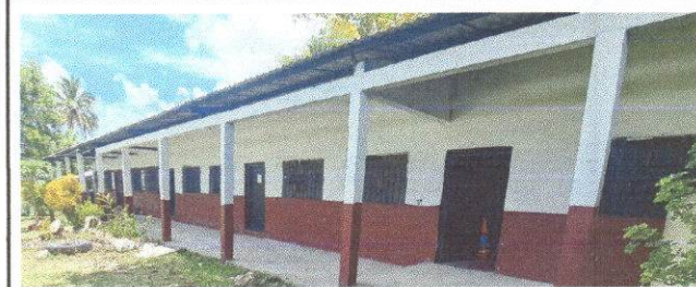
Foto 5: Pintura en muros exteriores e interiores
