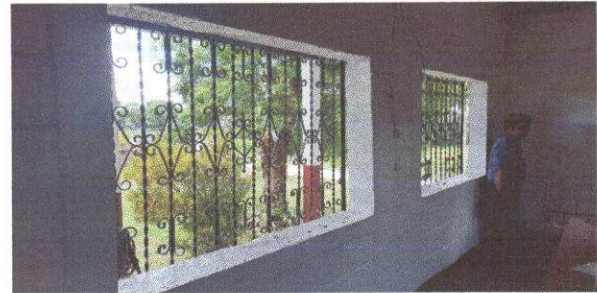
Foto 2: Fabricación e instalación de marcos de aluminio mil finish
