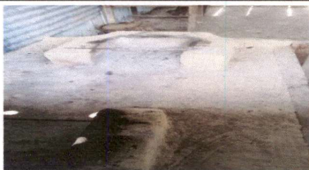
SUSTITUCIÓN DE COCINA RURAL COMPLETA
