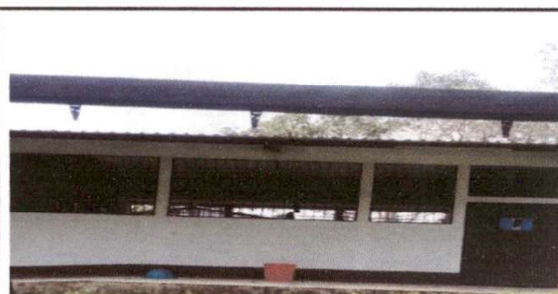
PINTURA EN MUROS EXTERIORES E INTERIORES
