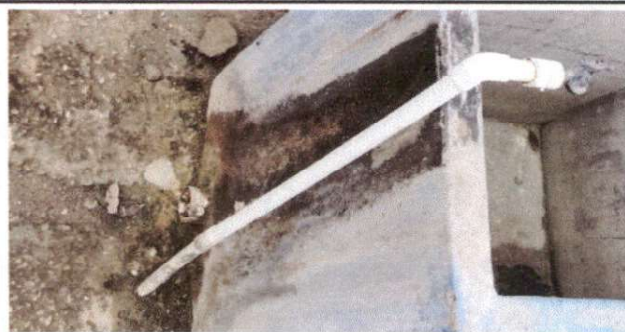
SUSTITUCIÓN DE TUBERIA PRINCIPAL
