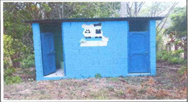
FOTO 2. SUSTITUCION DE PUETAS EN SERVICIO SANITARIO
