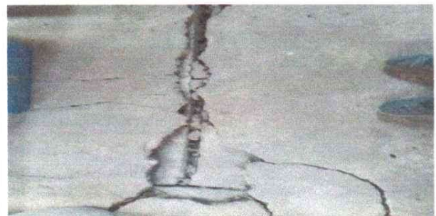
FOTO 6. SUSTITUCION DE TORTA DE CONCRETO
