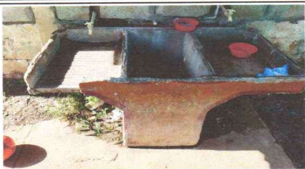
FOTO 7. SUSTITUCION DE PILA DE 2 LAVADEROS
