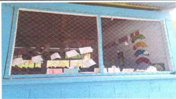
FOTO 1. SUSTITUCION DE BALCON
