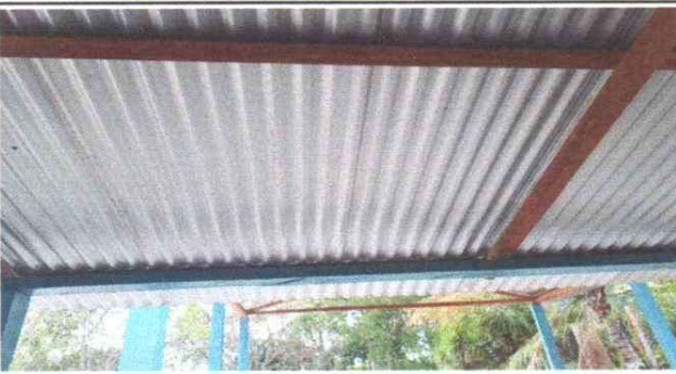
FOTO 3. SUSTITUCION DE ESTRUCTURA DE MADERA, POR METAL
