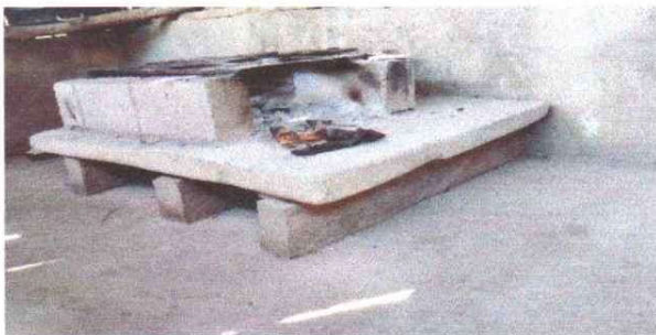
FOTO 5. SUSTITUCION DE COCINA RURAL COMPLETA INCLUYE CHIMENEA Y PLANCHA DE METAL
