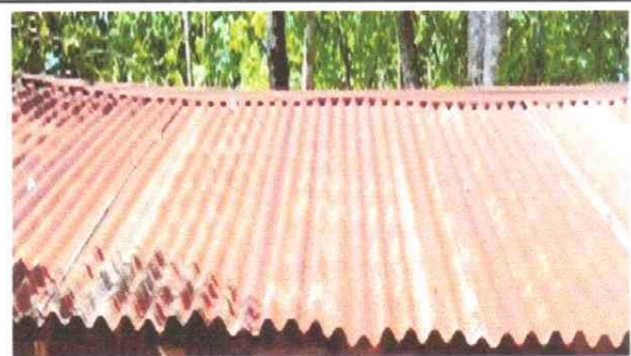
FOTO 4. SUSTITUCION DE LAMINA, POR LAMINA TROQUELADA ALUZINC CALIBRE 26
