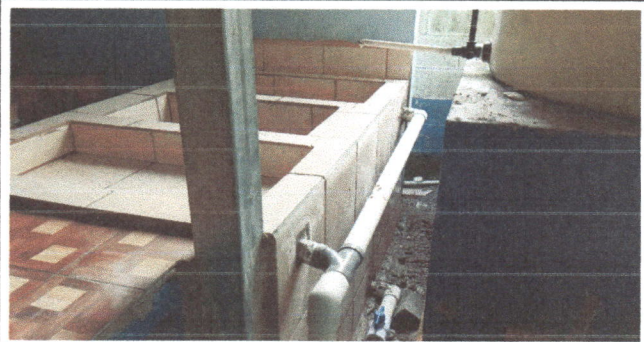
foto 6. sustitución de pila de cemento 2 lavaderos con capacidad de 275 galones
