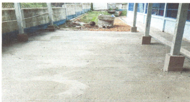
foto 3. sustitucion de torta de concreto
