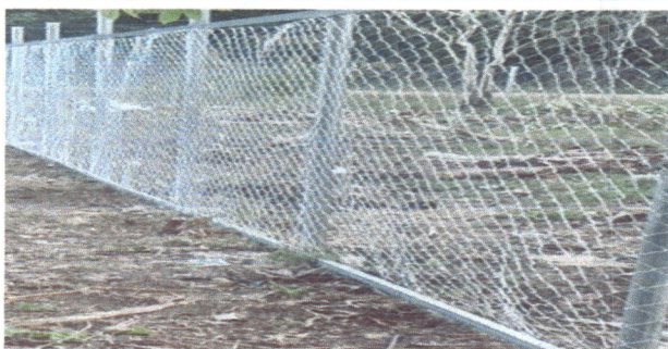
foto 5. reparacion de tubo hg y malla galvanizada
