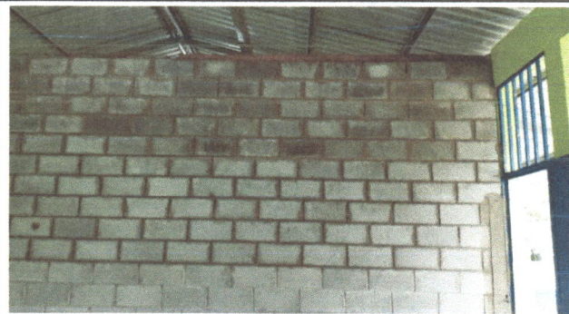
foto 4. reparacion de muro perimetral de block
