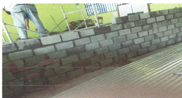
foto 4. reparacion de muro perimetral de block
