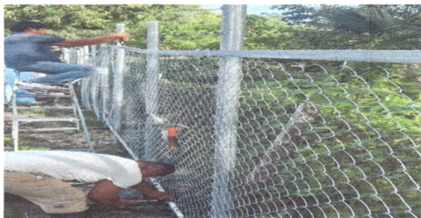
foto 5. reparacion de tubo hg y malla galvanizada
