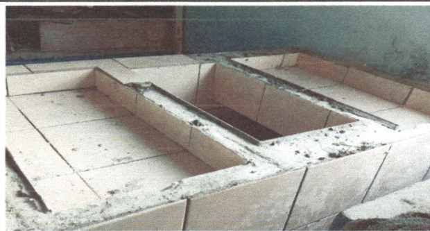
foto 6. sustitución de pila de cemento 2 lavaderos con capacidad de 275 galones
