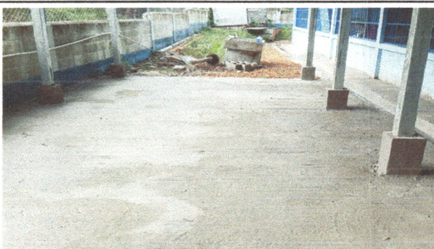
foto 3. sustitucion de torta de concreto
