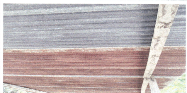
foto 2. sustitucion de estructura de soporte de madera por metal
