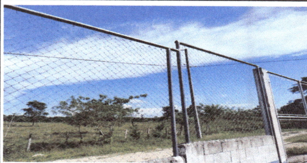
foto 5. reparacion de tubo hg y malla galvanizada
