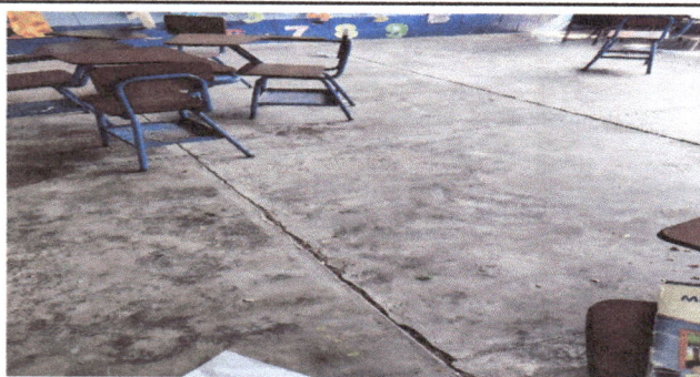
foto 3. sustitucion de torta de concreto
