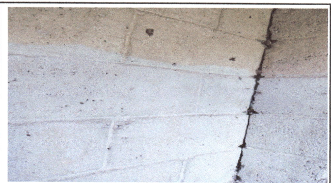
foto 4. reparacion de muro perimetral de block
