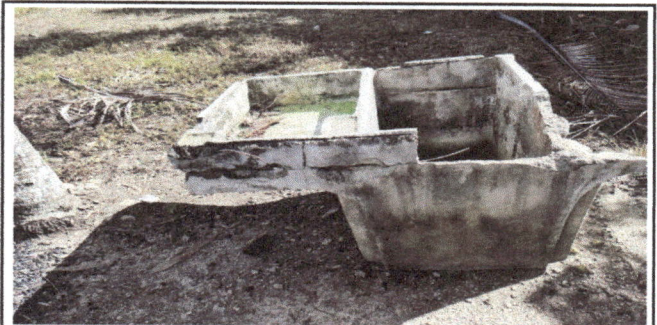
foto 6. sustitución de pila de cemento 2 lavaderos con capacidad de 275 galones
