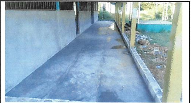
Foto 2: MEJORAMIENTO DE PISO
