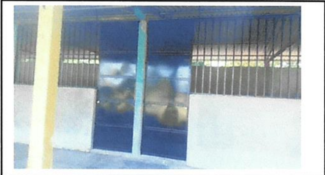
Foto 1: SUSTITUCIÓN DE PUERTAS
