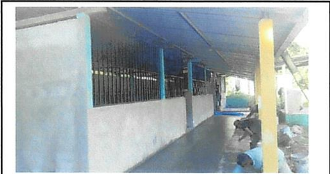
Foto 3: REPARACION DE VENTANAS
