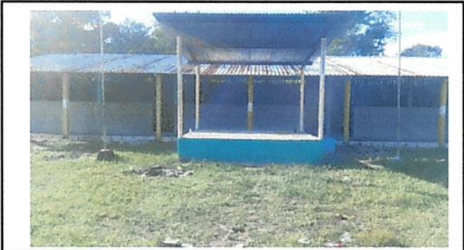
Foto 1:SUSTITUCIÓN DE PUERTAS
