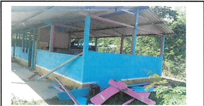
Foto 3: REPARACION DE VENTANAS
