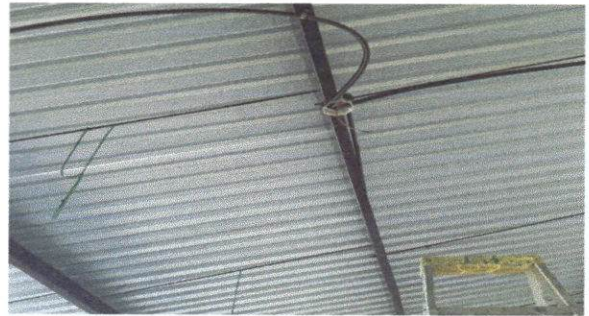
FOTO 8. SUSTITUCION DE PLAFONERAS
