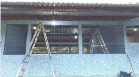
FOTO 11. REPARACION DEL CABLEADO ELECTRICO
