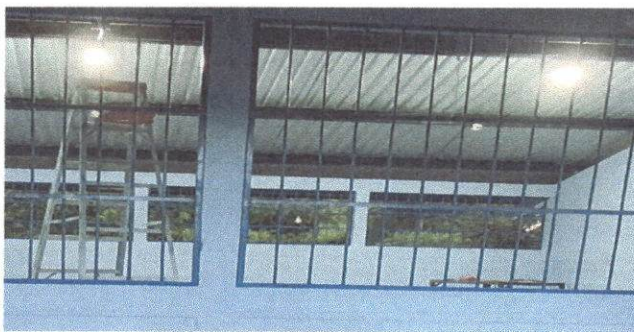
FOTO 5. SUSTITUCION DE BALCON DE METAL
