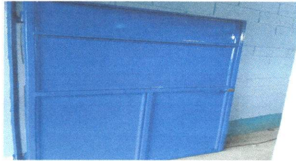
FOTO 3. MANTENIMIENTO A ESTRUCTURA DE PUERTAS
