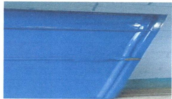
FOTO 4. SUSTITUCION DE CHAPA
