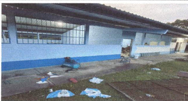
FOTO 5. SUSTITUCION DE BALCON DE METAL
