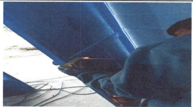
FOTO 4. SUSTITUCION DE CHAPA
