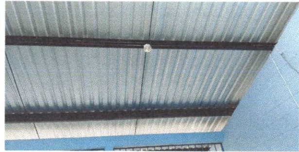
FOTO 8. SUSTITUCION DE PLAFONERAS
