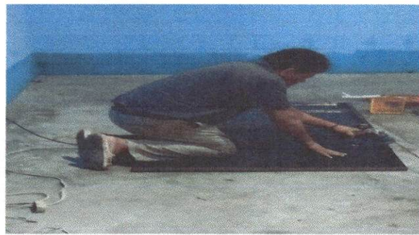
FOTO 3. MANTENIMIENTO A ESTRUCTURA DE PUERTAS
