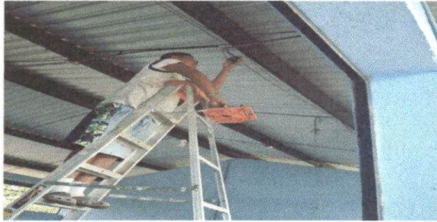
FOTO 7. SUSTITUCION DE FOCOS AHORRADORES
