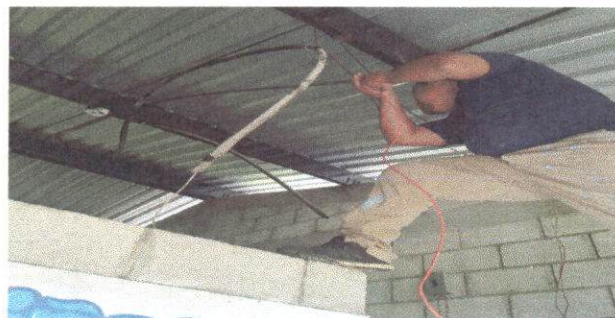
FOTO 11. REPARACION DEL CABLEADO ELECTRICO
