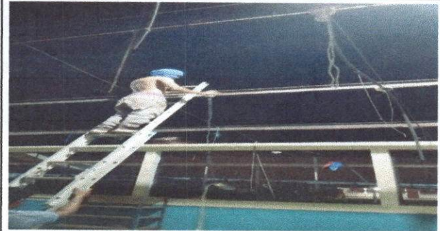
FOTO 2. MANTENIMIENTO A ESTRUCTURA DE SOPORTE DE METAL
