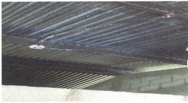
FOTO 7. SUSTITUCION DE FOCOS AHORRADORES
