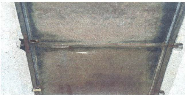
FOTO 3. MANTENIMIENTO A ESTRUCTURA DE PUERTAS
