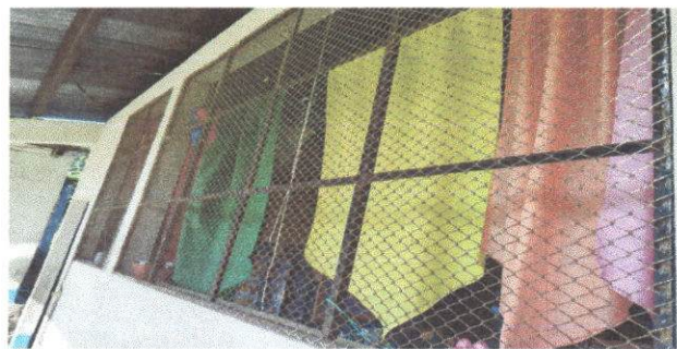
FOTO 5. SUSTITUCION DE BALCON DE METAL
