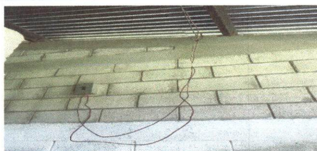
FOTO 11. REPARACION DEL CABLEADO ELECTRICO
