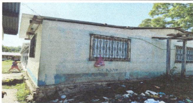
FOTO 6. PINTURA EN MUROS EXTERIOR E INTERIOR
