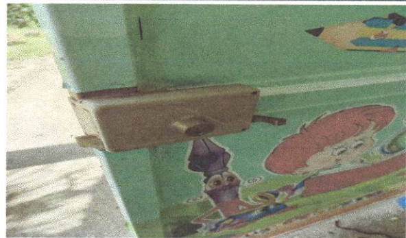
FOTO 4. SUSTITUCION DE CHAPA
