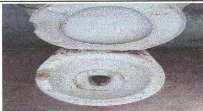
SUSTITUCIÓN DE INODOROS
