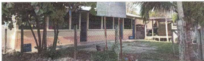
SUSTITUCION DE CERCO DE ALAMBRE DE PUA
