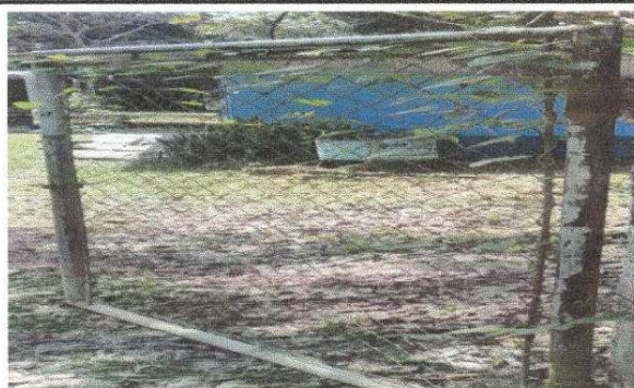
SUSTITUCION DE PORTON DE METAL
