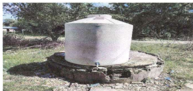
SUSTITUCIÓN DE DEPOSITO DE AGUA
