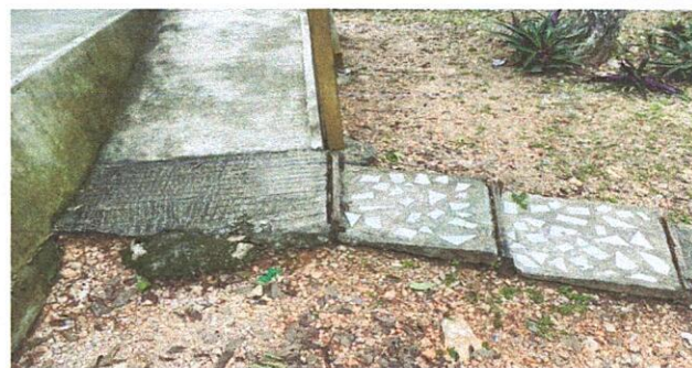
4. SUSTITUCION DE TORTA DE CONCRETO
