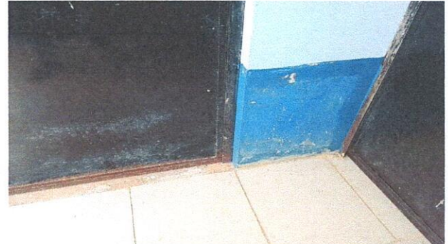
FOTO 8 MANTENIMIENTO A PUERTAS
