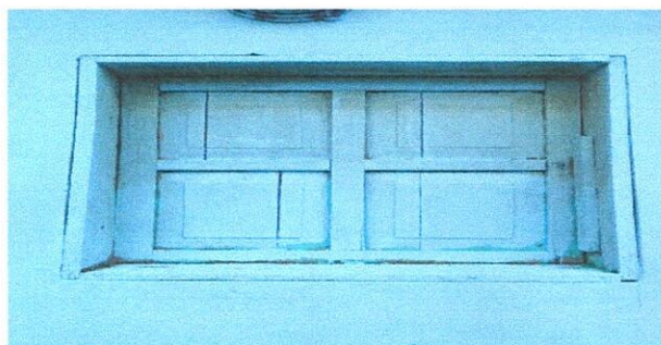
3. SUSTITUCION DE VENTANA DE MADERA, POR METAL MAS VIDRIO
