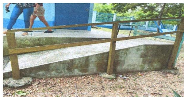
6. SUSTITUCION DE BARDA DE METAL
