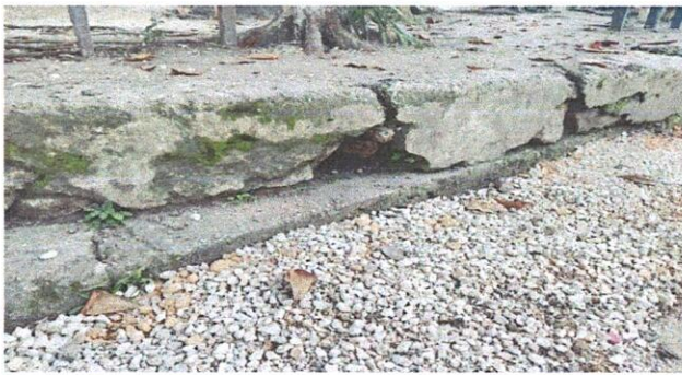
7. REPARACION DE MURO DE CONTENCION
