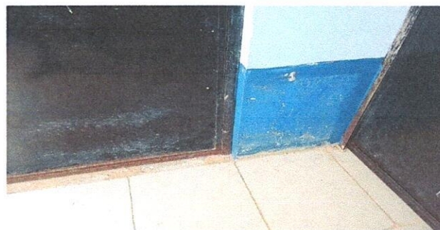
2. SUSTITUCION DE PORTON DE METAL
