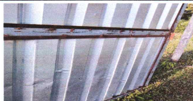
FOTO 6 SUSTITUCION DE PORTON DE METAL
