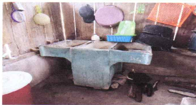
FOTO 9. SUSTITUCION DE PILA DE 2 LAVADEROS
