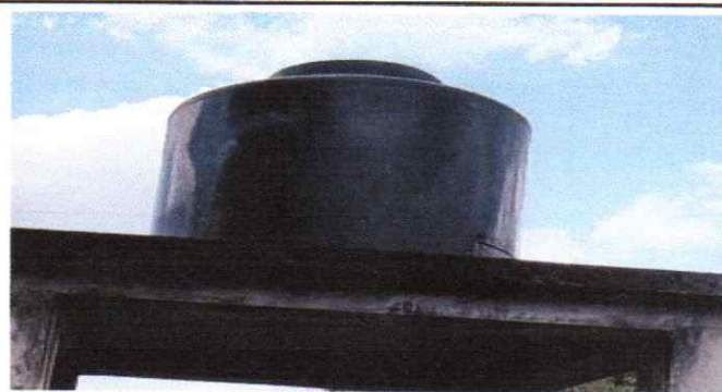
FOTO 8. SUSTITUCIÓN DE DEPOSITO DE AGUA 1.700 LITROS
