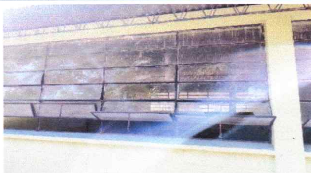
FOTO 2. SUSTITUCION DE BALCON DE METAL
