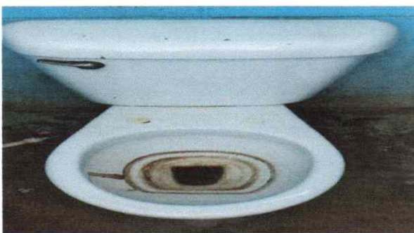
FOTO 4. SUSTITUCIÓN DE INODOROS
