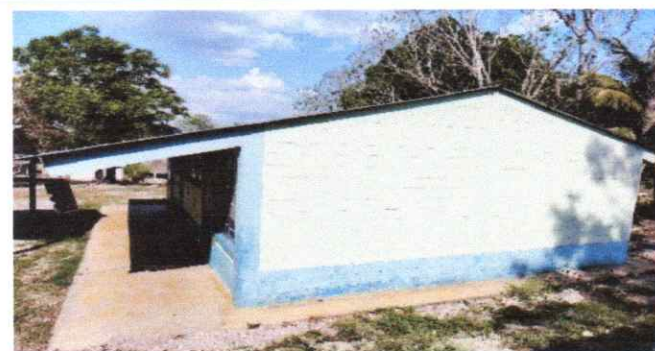
FOTO 3. PINTURA EN MUROS EXTERIORES E INTERIORES
