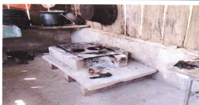
FOTO 10. SUSTITUCION DE ESTUFA RURAL COMPLETA incluye chimenea y plancha de metal
