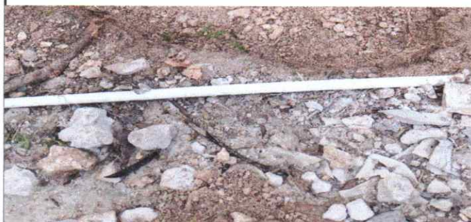
FOTO 7. SUSTITUCION DE TUBERIA PRINCIPAL
