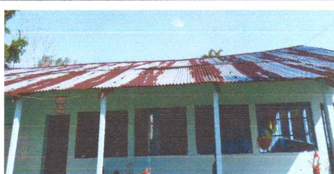
Foto 2: Sustitución de capote de lámina por alámina troquelada
