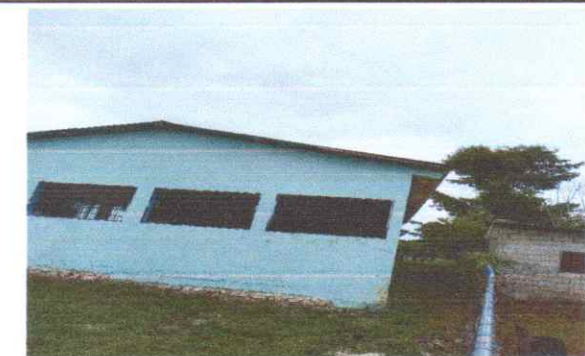
Foto 3: Sustitución de elementos de fijación
