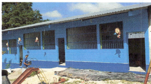
Foto 3: Sustitución de balcones de metal.
