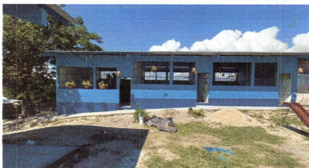
Foto 5: Pintura en muros exteriores e interiores
