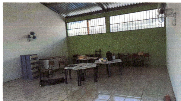
Foto 4: Sustitución de piso liso por piso cerámico.
