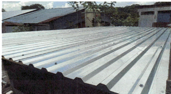
Foto 1: Sustitución de lámina, por lámina troquedala alizinc calibre 26
