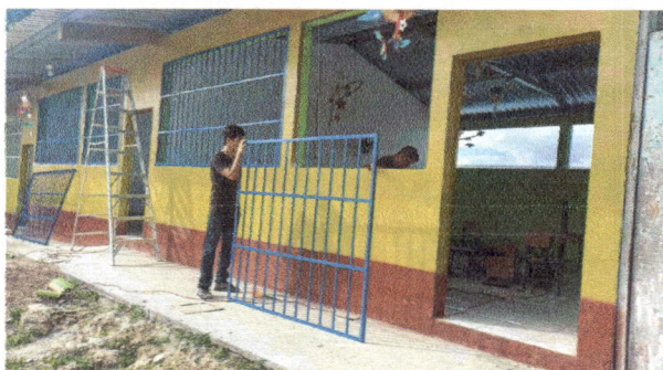
Foto 3: Sustitución de balcones de metal.
