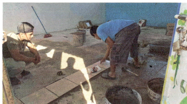
Foto 4: Sustitución de piso liso por piso cerámico.
