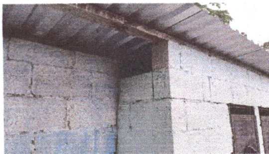
Foto 1: Sustrución de lámina, por lámina troquedala alizinc calibre 26
