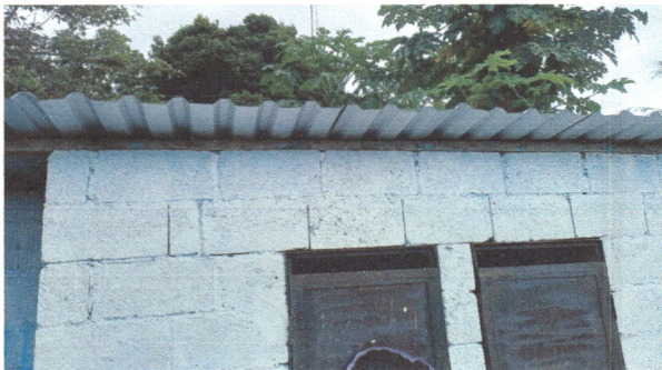
Foto 7: Reparacion en muros y cernidos de paredes.
