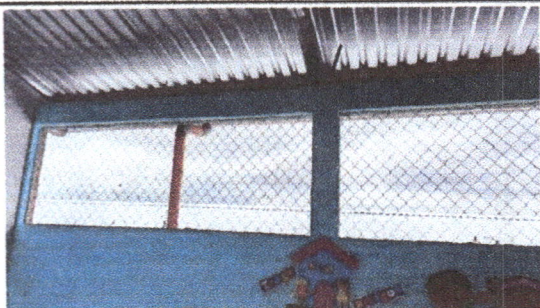
Foto 3: Sustrución de balcones de metal.
