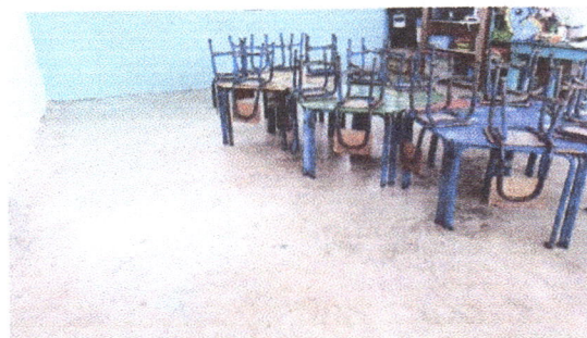
Foto 4: Sustrución de piso liso por piso cerámico.
