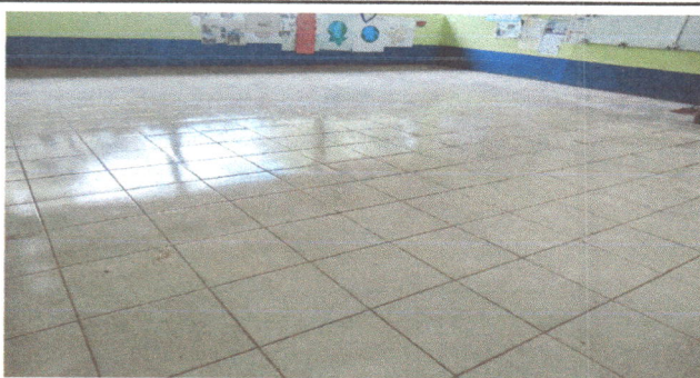
FOTO 3. MEJORAMIENTO DE PISO LISO POR CERAMICA
