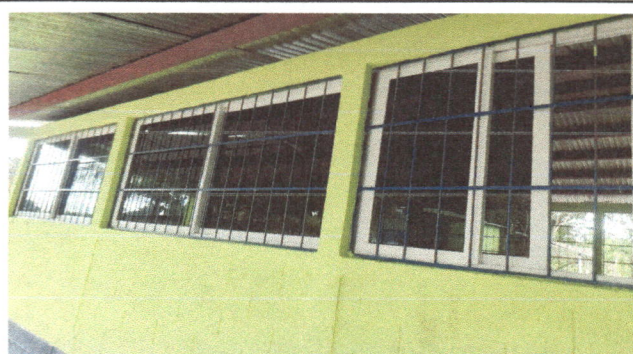
FOTO 8. SUSTITUCION DE VENTANAS DE METAL MAS VIDRIO
