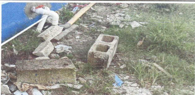
FOTO 5. SUSTITUCION DE TUBERIA DE PVC, LINEA PRINCIPAL DE AGUAS NEGRAS
