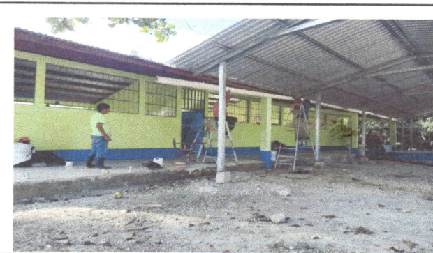
FOTO 4. SUSTITUCION DE CANAL DE PVC
