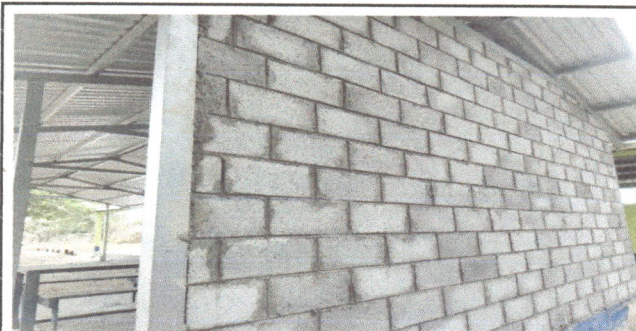
FOTO 6. REPARACION DE MURO PERIMETRAL DE BLOCK
