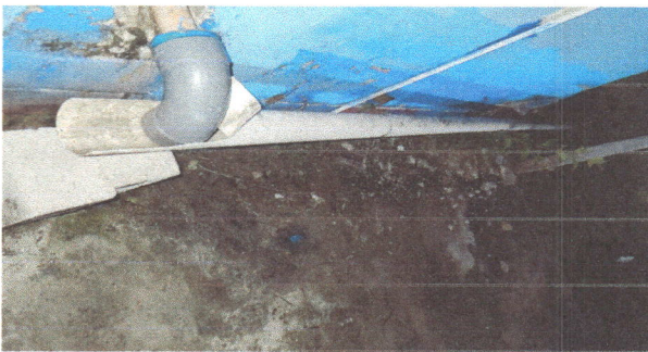
FOTO 5. SUSTITUCION DE TUBERIA LINEA PRINCIPAL DE AGUAS NEGRAS
