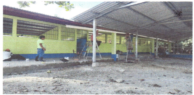
FOTO 4. SUSTITUCION DE CANAL DE PVC
