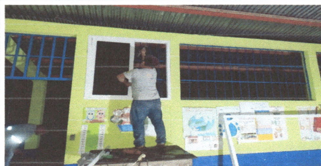
FOTO 8. SUSTITUCION DE VENTANAS DE METAL MAS VIDRIO
