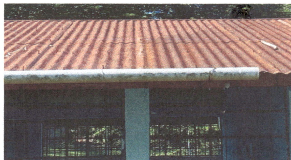
FOTO 4. SUSTITUCION DE CANAL DE PVC
