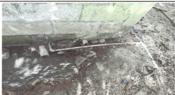
FOTO 5. SUSTITUCION DE TUBERIA PVC LINEA PRINCIPAL DE AGUAS NEGRAS
