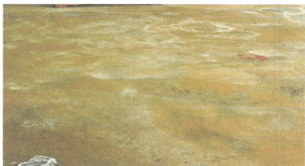
FOTO 3. MEJORAMIENTO DE PISO LISO, POR CERAMICA
