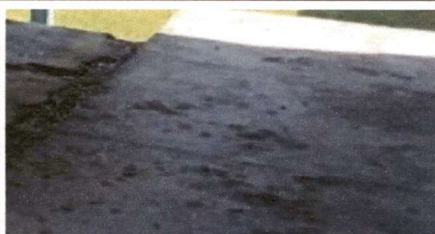
SUSTITUCION DE PISO DE TORTA DE CONCRETO
