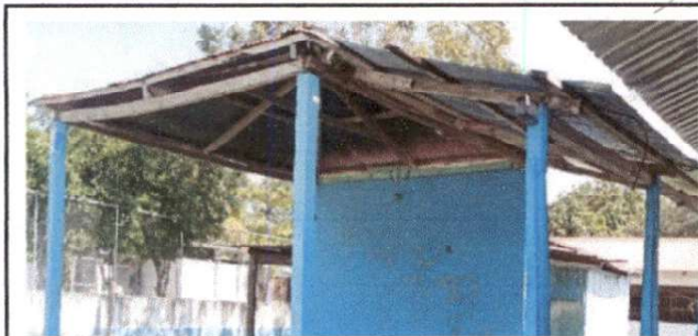
FOTO 1. SUSTITUCION DE ESTRUCTURA DE SOPORTE DE MADERA POR METAL
