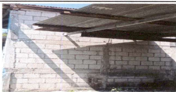
REPELLO EN MURO
