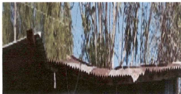
FOTO 2. SUSTITUCIÓN DE LAMINA, POR LAMINA TROQUELADA ALUZING CALIBRE 26
