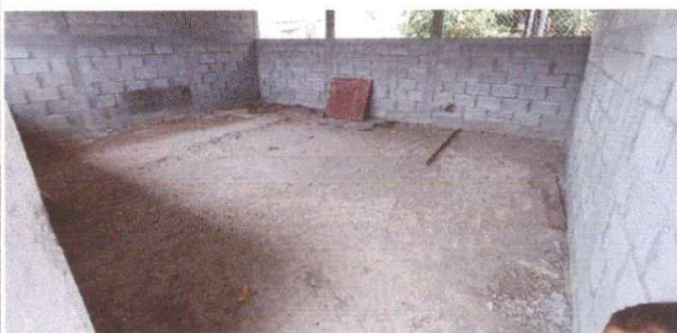
Foto 6: Pintura en muros exteriores e interiores
