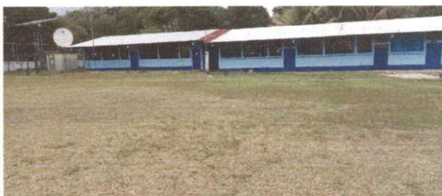
Foto 4: Sustitución de puerta
