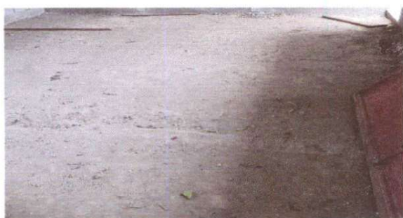
Foto 3: Sustitución de cemento líquido
