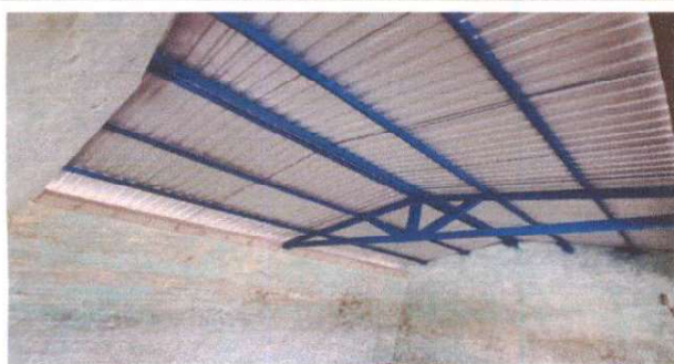
Foto 1: Reparación de repello y cernido de paredes
