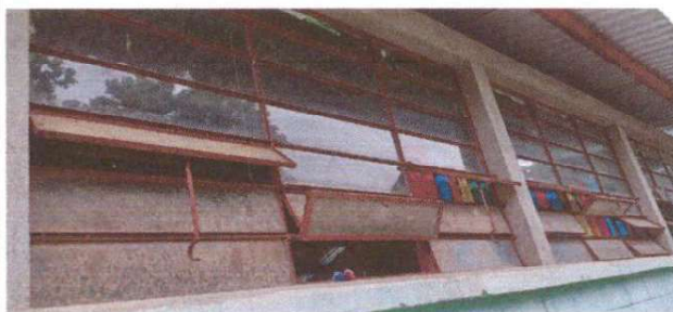
Foto 2: Fabricación e instalación de balcones
