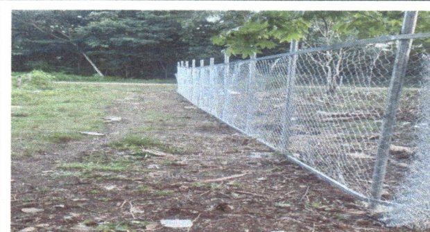
FOTO 6. REPARACION DE TUBO HG Y MALLA GALVANIZADA
