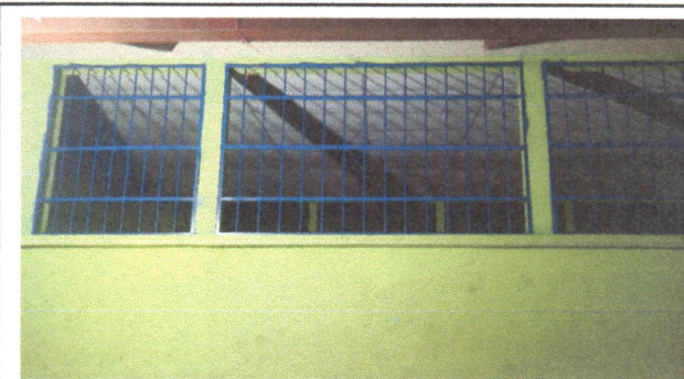
FOTO 4. MANTENIMIENTO EN BALCON DE METAL
