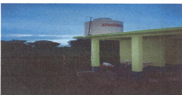
FOTO 5. SUSTITUCION DE DEPOSITO DE AGUA DE 1,100 LITROS
