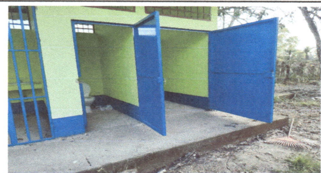
FOTO 3. SUSTITUCION DE PUERTA EN SERVICIO SANITARIO
