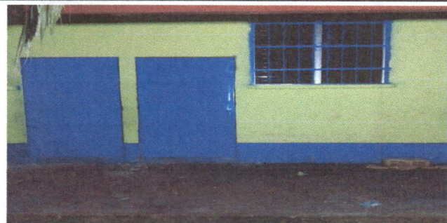
FOTO 1. MANTENIMIENTO A ESTRUCTURA
