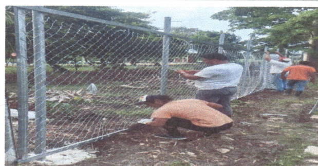
FOTO 6. REPARACION DE TUBO HG Y MALLA GALVANIZADA
