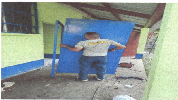
FOTO 3. SUSTITUCION DE PUERTA EN SERVICIO SANITARIO
