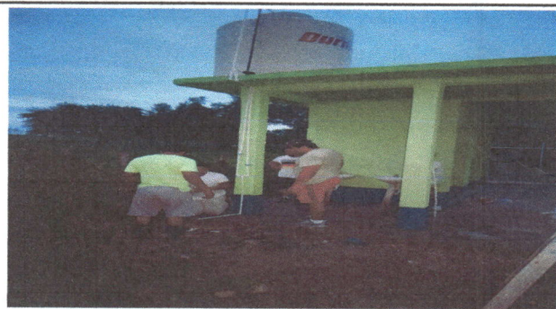
FOTO 5. SUSTITUCION DE DEPOSITO DE AGUA DE 1,100 LITROS
