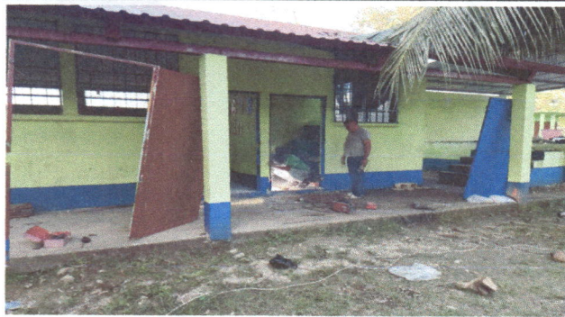
FOTO 1. MANTENIMIENTO A ESTRUCTURA
