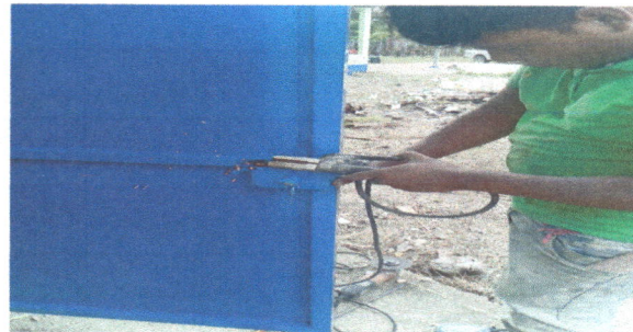
FOTO 2. SUSTITUCION DE CHAPA
