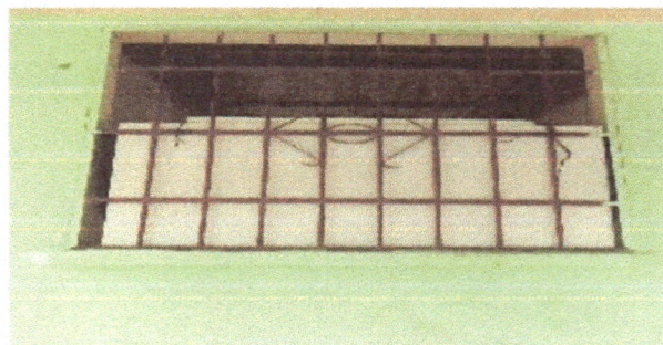
FOTO 4. MANTENIMIENTO EN BALCON DE METAL
