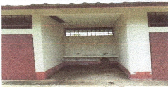
FOTO 3. SUSTITUCION DE PUERTA EN SERVICIO SANITARIO
