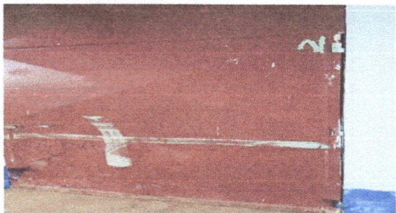
FOTO 1. MANTENIMIENTO A ESTRUCTURA
