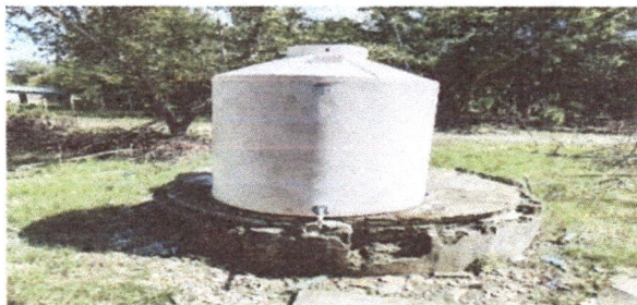
FOTO 5. SUSTITUCION DE DEPOSITO DE AGUA DE 1,100 LITROS
