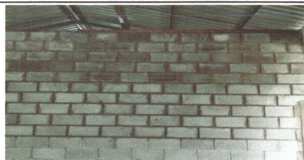
foto 6. reparacion de muro perimetral de block
