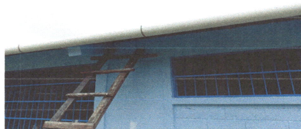
foto 4. sustitucion de canal de PVC
