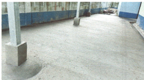
foto 3. sustitucion de torta de concreto
