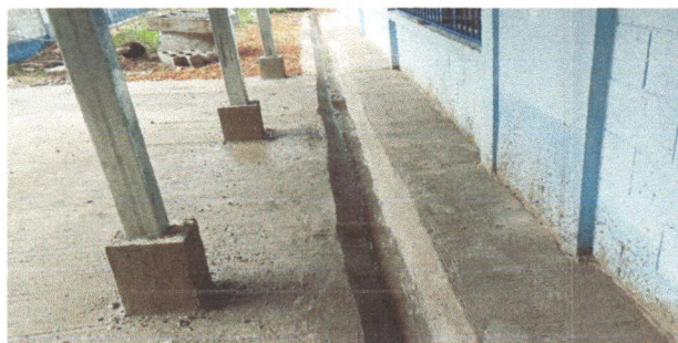
foto 5. reparacion de cuneta de concreto
