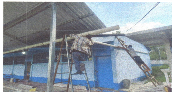
foto 4. sustitucion de canal de PVC
