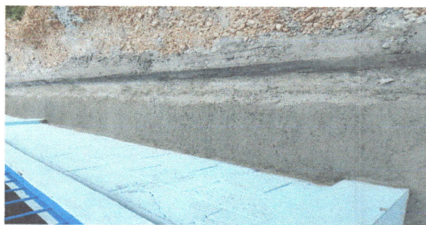
foto 5. reparacion de cuneta de concreto
