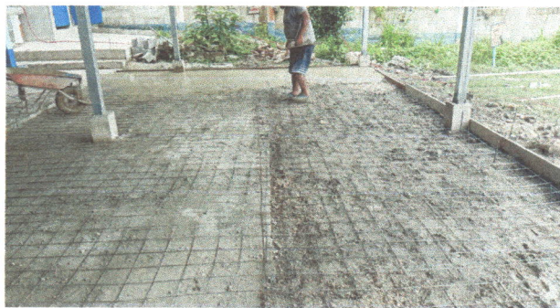
foto 3. sustitucion de torta de concreto
