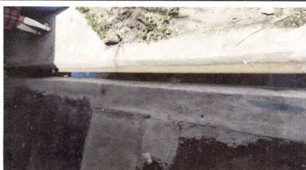
foto 5. reparacion de cuneta de concreto
