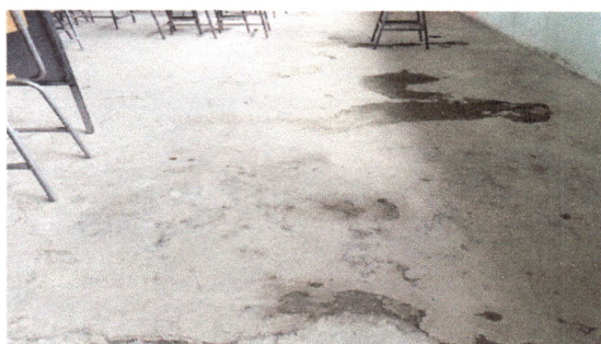
foto 3. sustitucion de torta de concreto
