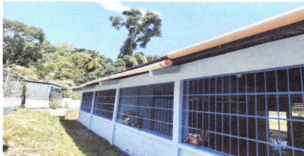
foto 4. sustitucion de canal de PVC
