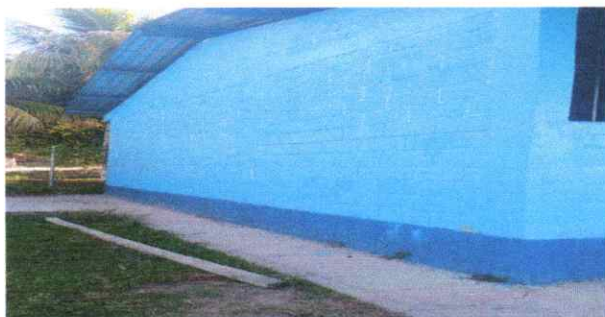
Foto 3: Pintura en muros exteriores e interiores
