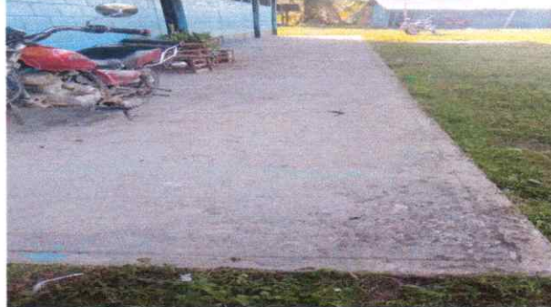
Foto 2: Piso Sustitucion de torta de piso de concreto
