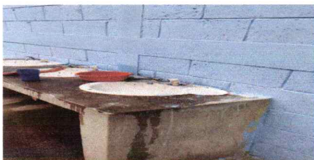
Foto 5: Mano de obra especializada (albañileria Erreria Electricidad y plomeria) instalacion de tablero y filipones instalacion de tabamanos instalacion de tuberia pvc instalacion de chorros
