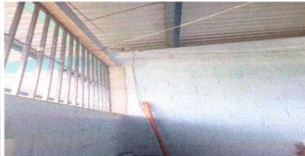
Foto 4: Reparacion de sistema electrico sustitucion de focos aorradores sustitucion de plafonares y sustitucion de interruptores simples sustitucion de interruptores dobles sustitucion de tomacorrientes dobles, reparacion de cabiado numero # 10, reparacion de cabiado #12 reparacion de cabiado #8 Lampara tipo lec (reflectores) sustitucion de Ducto electrico mas
