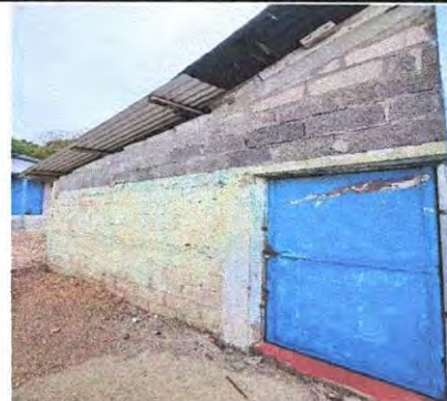
Foto 10: Repello en muro
