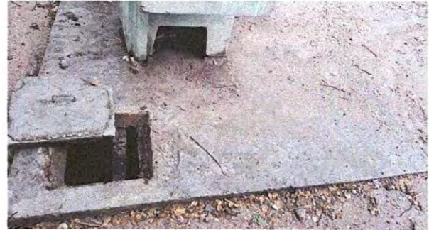
Foto 8: Limpieza de fosa séptica
