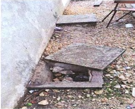
Foto 7: Mantenimiento a cajas de registro
