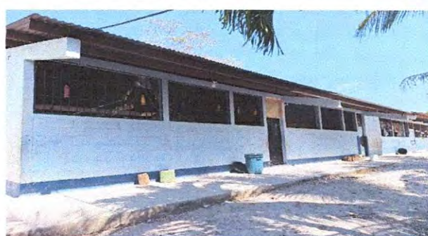
Foto 6: Pintura en muros exteriores e interiores
