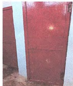
Foto 4: Sustitución de puertas en servicios sanitarios
