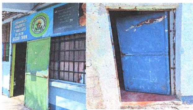
Foto 3: Sustitución de puertas
