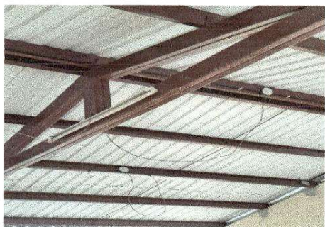
Foto 1: Reparación de Sistema Eléctrico
