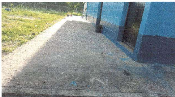
Foto 9: Reparación de planchas de concreto de patio
