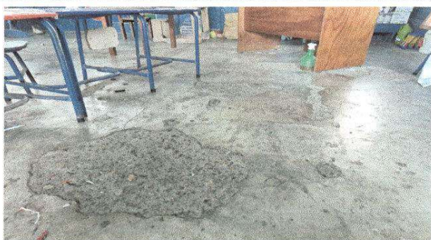
Foto 5: Sustitución de piso de cemento líquido
