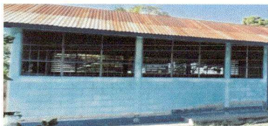
Foto 4: Pintura en muros interior y exterior
