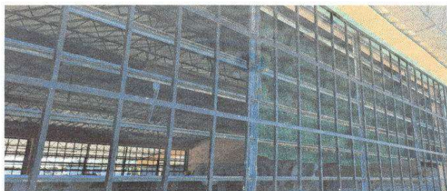
Foto 3: Fabricación e Instalación de Balcones
