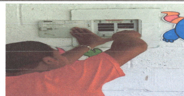
foto 12. sustitucion de flipones 2
