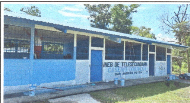
foto 5, pintura en muros exteriores e interiores
