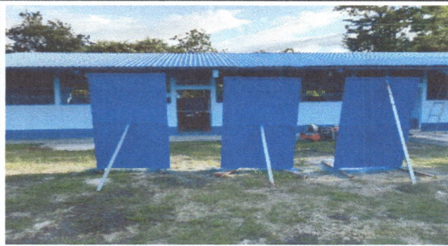
foto 1. mantenimiento a estructura (lijada, cepillada y aplicación de pintura)
