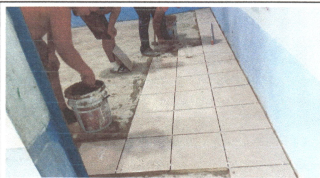
FOTO 4 SUSTITUCIÓN DE PISO DE CERAMICA
