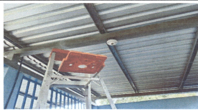
foto 9. sustitucion de plafonera
