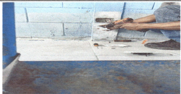
foto 11. sustitucion de tomacorrientes dobles
