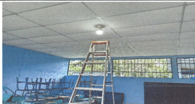
foto 8. sustitucion de focos ahorradores
