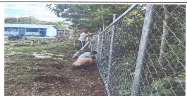
foto 6. reparacion de tubo HG y malla galvanizada
